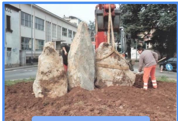
Posa della terza pietra
