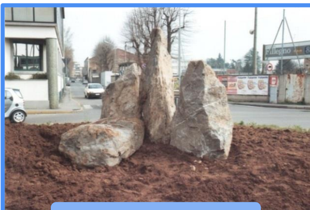
Posa della pietra di base
